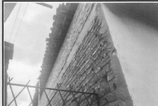
FOTO 04 - ALVENARIA EM TIJOLOS DE ADOBE (BARRO) SEM REVESTIMENTO EXTERNO
